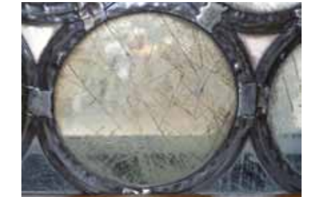
Abb.2 Butzenscheiben in Bleifassung waren im Mittelalter gängige Form der Verglasung.
