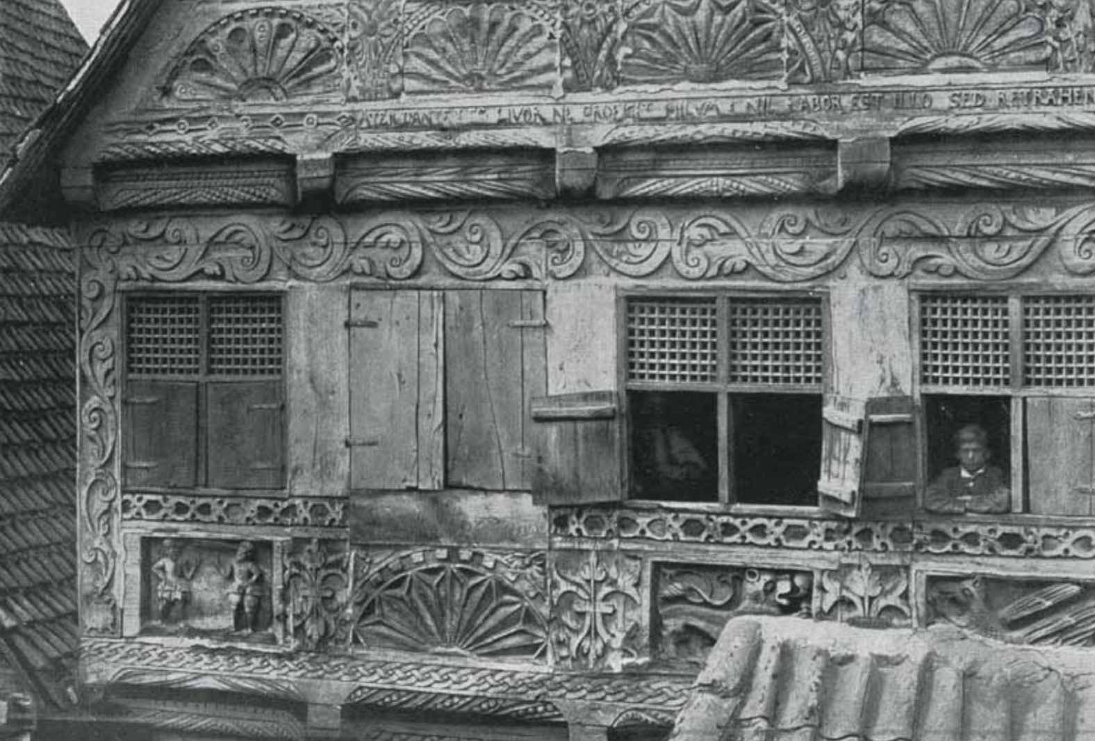
Abb.1 Fachwerkhaus um 1900, immer noch mit hölzernen Läden und Gittereinsätzen
