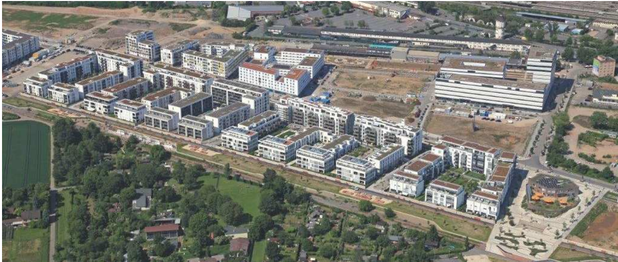
Abbildung 1: Luftbild des Teils der Bahnstadt, in dem sich die hier untersuchten Gebäude befinden (Foto: Kay Sommer / Bildrechte Stadt Heidelberg)
